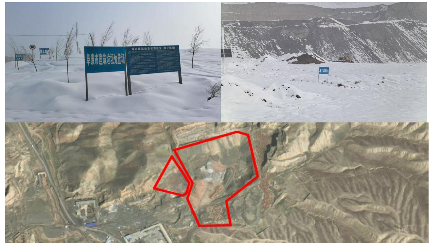
图 3-4 小红沟建筑垃圾堆填场
