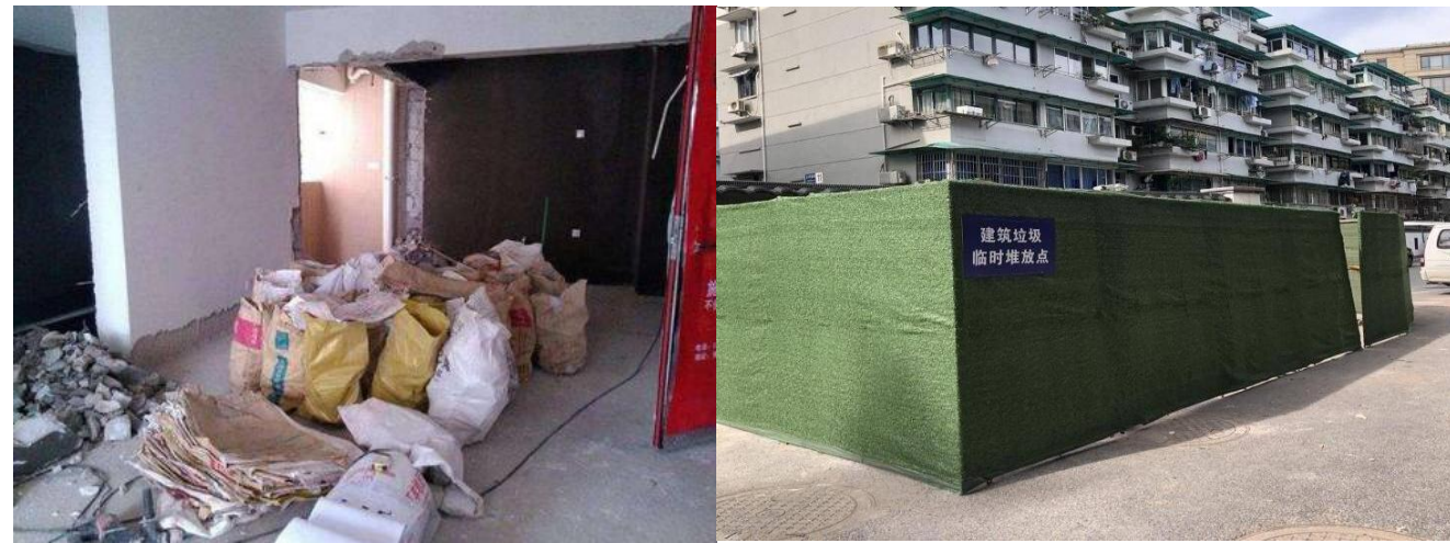
图 5-1 装修现场及装修垃圾堆放点示意图
