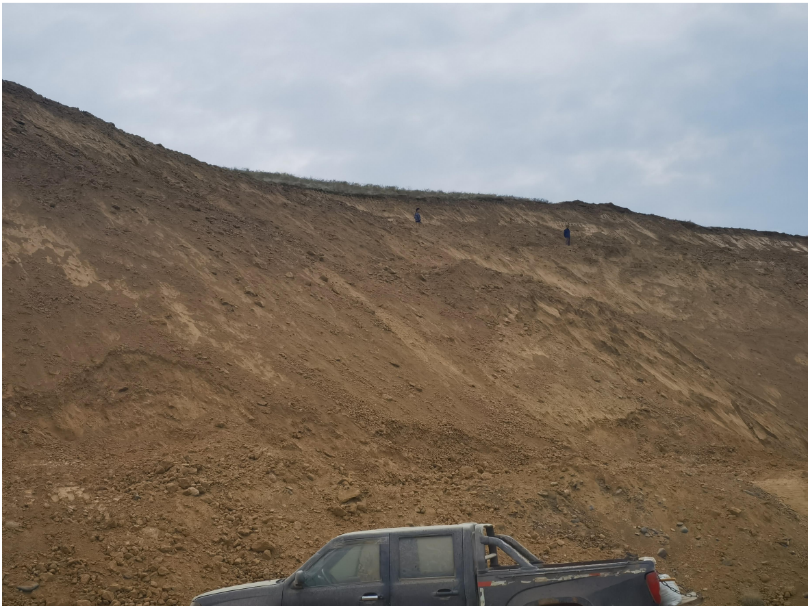
照片 2-1 现状露天采场
